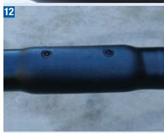
A questo punto, l'installazione del giunto di ripristino a singola tenuta è completato.
